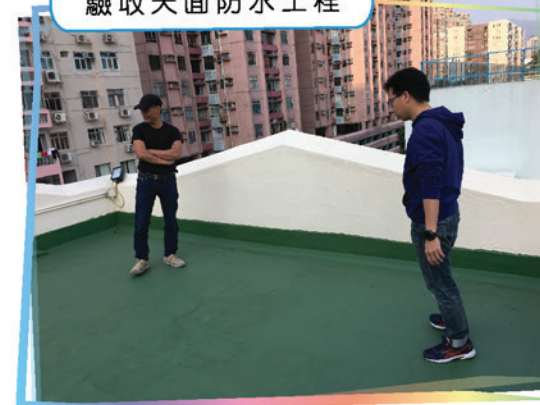
驗收天面防水工程
